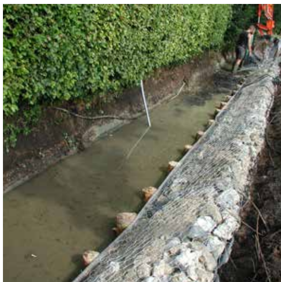
Oeverversteving met schanskorven (metalen gaasnet gevuld met steenachtige materialen)
