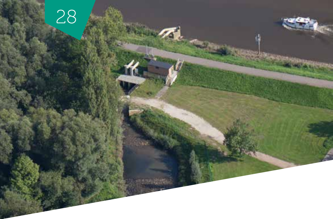
Samenwerkingsproject met Aquafin: aanleg overstroomingsgebied en pompstation aan de monding van de Molenveldloop in Duffel
